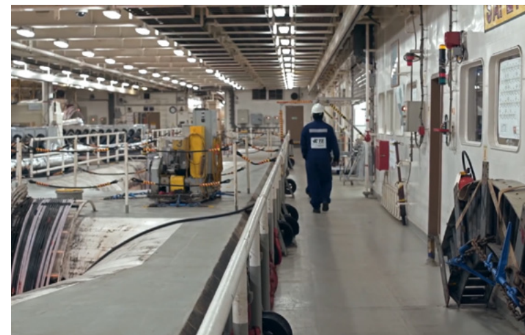
El interior del barco "Dependable" de instalación de cables de fibra óptica amarrado en el puerto de Santurce (Bilbao). Fuente: Telefónica-Telxius.
